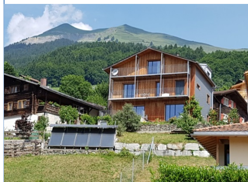
EFH Baujahr 2007 / Minergie-P-Standard
