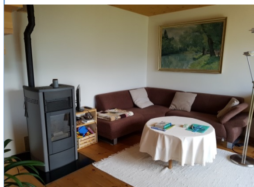
Der Pellet Zentralheizungsofen MCZ Ego Hydro ersetzt einen vorgängigen Holz-Zentralheizungsofen.
