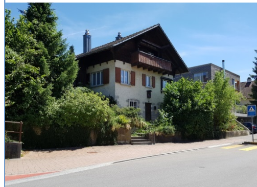
Teilsaniertes EFH in Schaan mit Baujahr 1940
