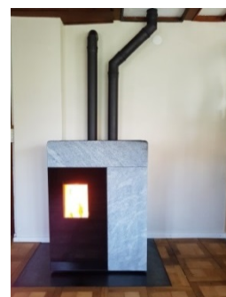
Rika Domo Multiair Pelletofen mit den abgehenden Warmluft-Verteilungen
