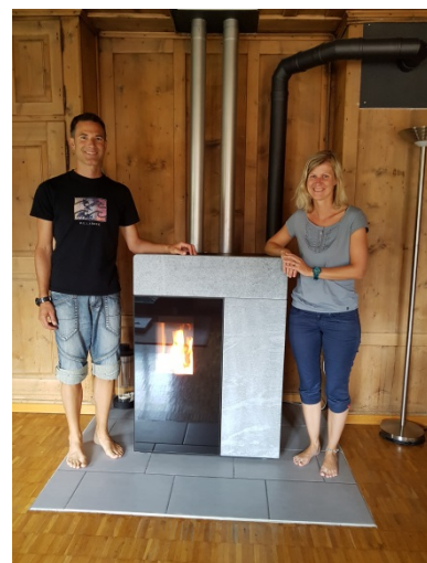
Familie Florin bewohnt seit März 2017 die Wohnung im 2. Stock. In der Stube beheizt der Rika Domo Multiair Pelletofen zusätzlich über die Warmluftleitungen 2 weitere Räume.
